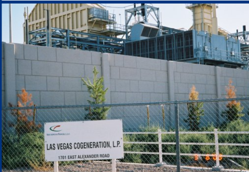
Las Vegas Cogeneration Plant - Las Vegas, Nevada
